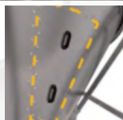
Escotilha de inspeção
